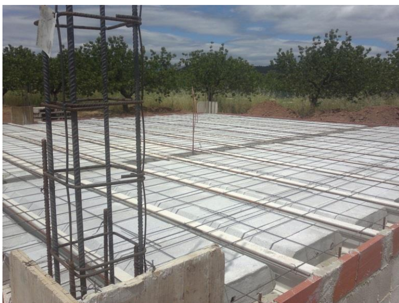
Forjado sanitario de la vivienda
