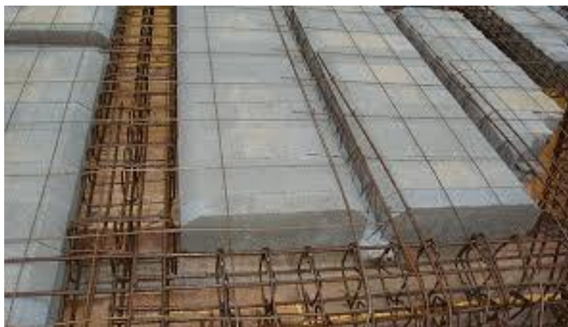
Forjado cubierta: unidireccional semiviguetas armadas con zapatilla
